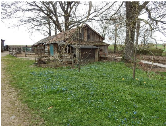
Abbildung 5: Flur-Nr. 1/2, Blick Richtung Westen zur Pferdestallung mit Werkstatt.
